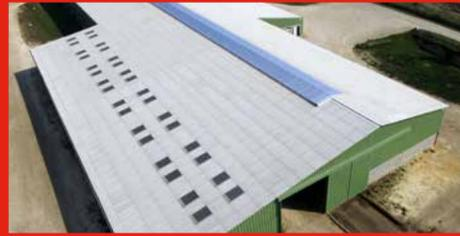
Pour optimiser la lumière naturelle de votre stablation, le faitage éclairant Zenitec ou les plaques translucides Clairflex vous permettront d'aménager votre toiture. Les solutions Zenitec ou Clairflex se combinent aisément avec les plaques ondulées en fibres-ciment et assurent une bonne répartition de la lumière intérieure.
