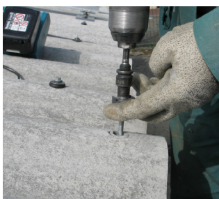
3) Pour le vissage, veillez à bien tirer sur la vis afin que la cale puisse être en contact avec la plaque fibres-ciment
