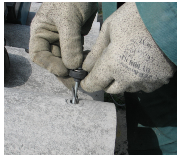
2) Mise en place de la vis en positionnant la cale de pincement parallèle à la vis
