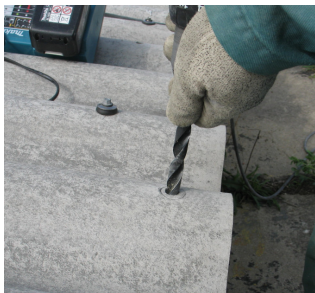
1) Pré-perçage au foret diamètre 13 mm
