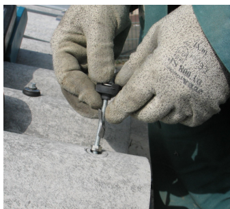
2) Mise en place de la vis en positionnant la cale de pincement parallèle à la vis
