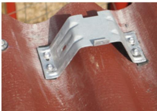
Pour l'ancrage des fixations des plaques aux pannes, sont **exclus d'emploi**, les outils de typologie analogues suivants : visseuse à chocs, boulonneuse, clef à chocs, perceuse-visseuse avec mode percussion enclenché ou bien intégré par défaut, perforateur ou bien marteau perforateur.
