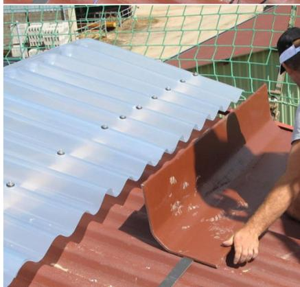
Mise en place des faîtières pare-vent en fibres-ciment en les positionnant à 150 mm du bord du lanterneau PVC.
