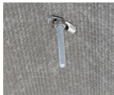
5) Vue de dessous : fixation par pincement de la cale sur le support fibres-ciment
