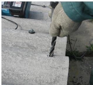
1) Pré-perçage au foret diamètre 13 mm
