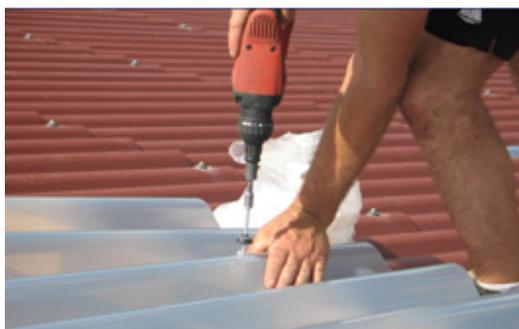
Mise en place du pontet et fixation du lanterneau en sommet d'onde à l'aide de fixation standard.
