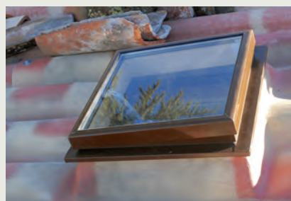
Pose de la fenêtre de toit
