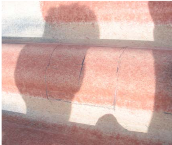
Position du trou sur la 3 ème onde de la plaque SOUTUILE 230 FR Dimension du trou 20 x 20 cm
