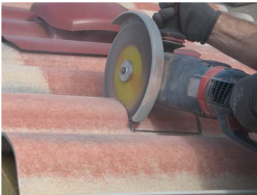
Découpe de la plaque SOUTUILE 230 à la disceuse
